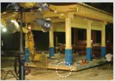
壊れやすい建造物の移動にもスピードローラーが万全のサポート。
