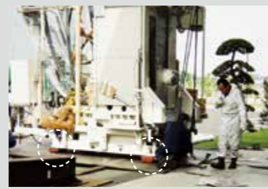
重量物の移動には床面保護のため、鉄板等による養生を行い搬送します。
